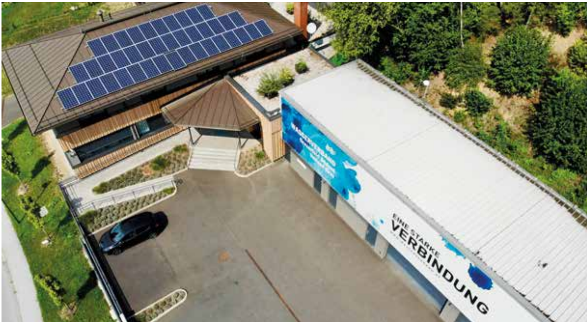
Das Verbandsgebäude des Wasserverbands Grazerfeld Südost mit PV-Anlage auf dem Dach. Credit: Wasserverband Grazerfeld Südost
