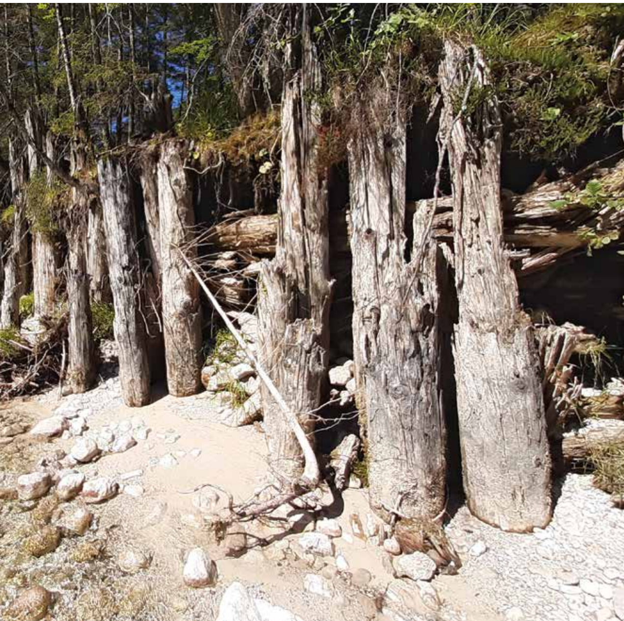
Die Überreste des Auffangrechsens am Lassingbach. Credit: Veronika Frank
